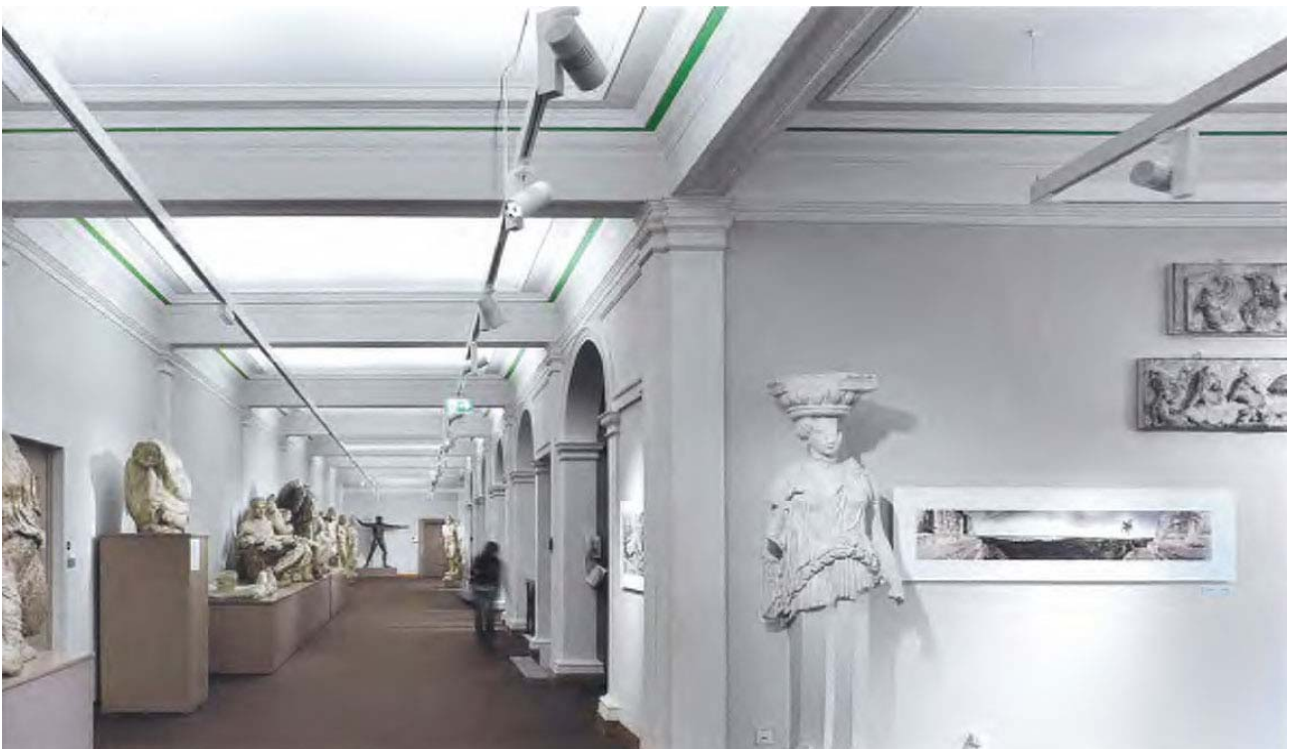
Korridor im Obergeschoss mit indirekter Deckenbeleuchtung und LED-Strahler
