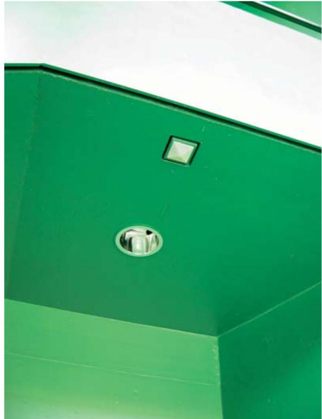
Lichtsensor im Fluchttreppenhaus. Das klobige Bauteil wurde in den Beton eingelassen und auf die minimale Erscheinung reduziert.
